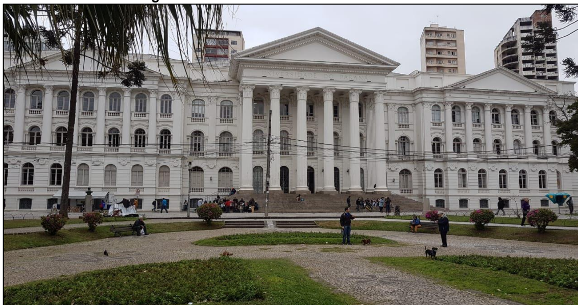
Figura 10 – Fachada do Prédio Histórico da UFPR
